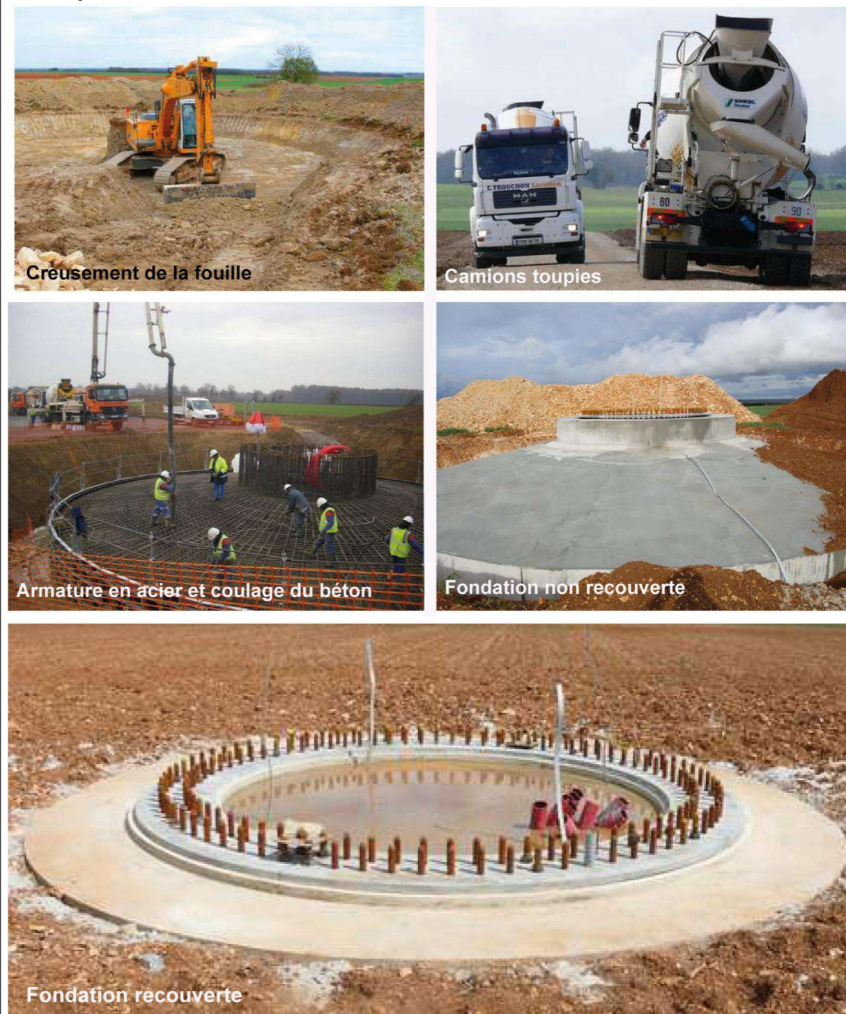
Photographie 52 : Etapes de réalisation d'une fondation d'éolienne
