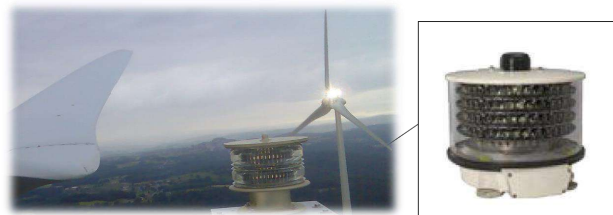
Figure 35 : Balisage d'une éolienne
