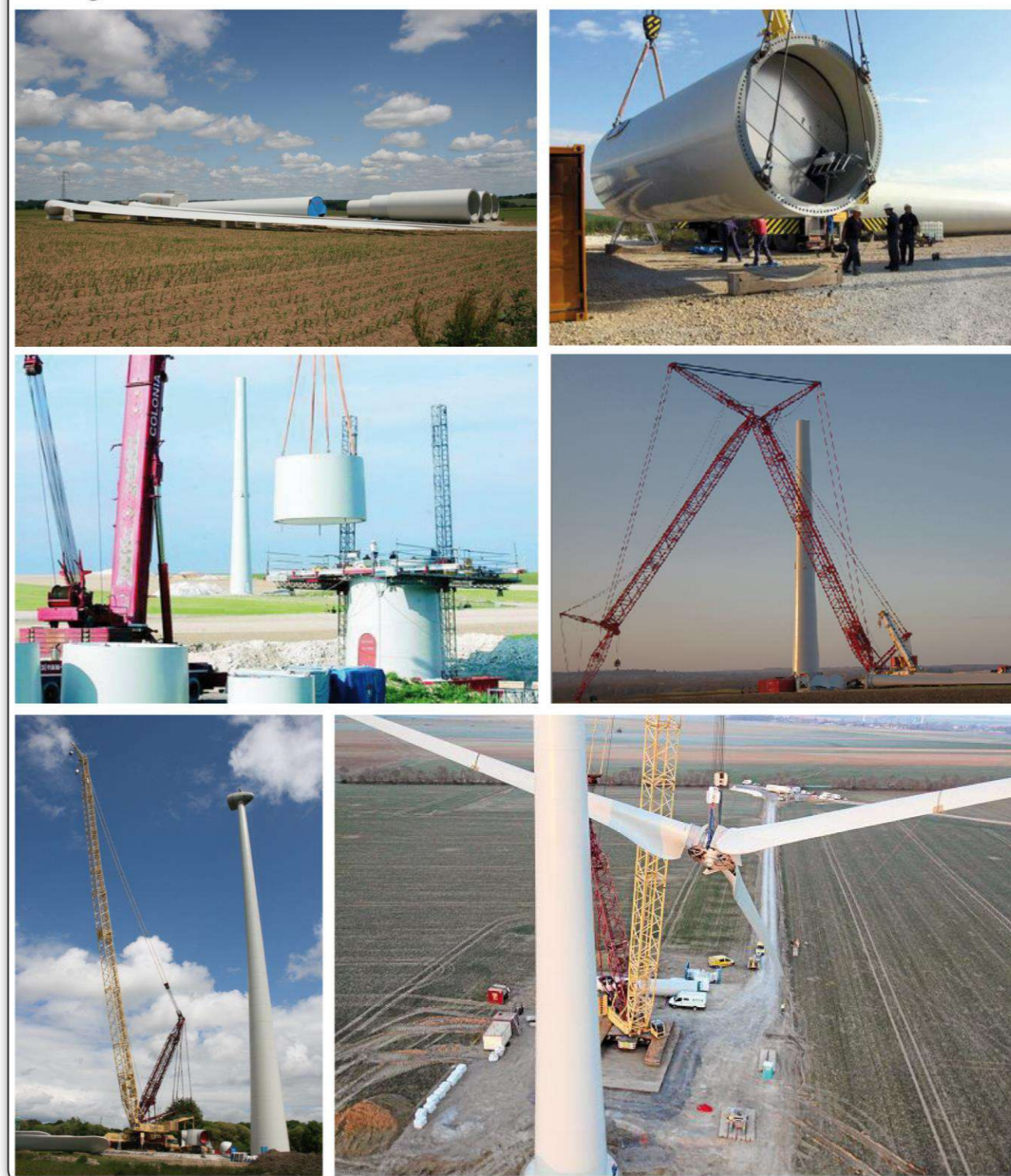
Montage d'une éolienne
