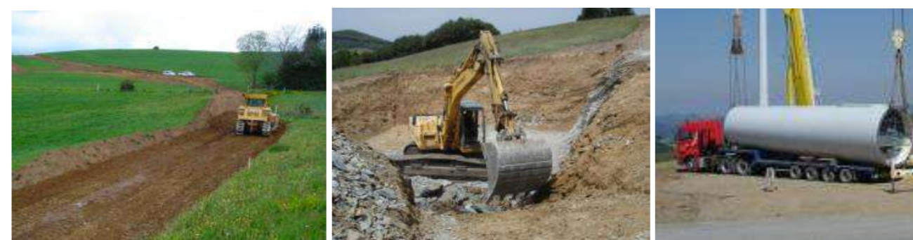
Photographie 58 : illustration d'un chantier éolien
